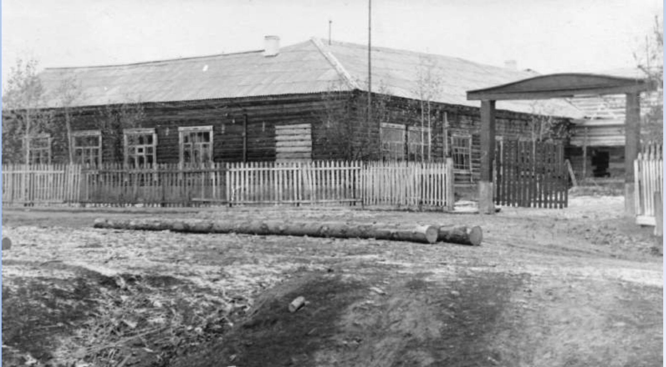
В 1960-е годы – восьмилетняя Курлекская школа. Здание разрушено.
