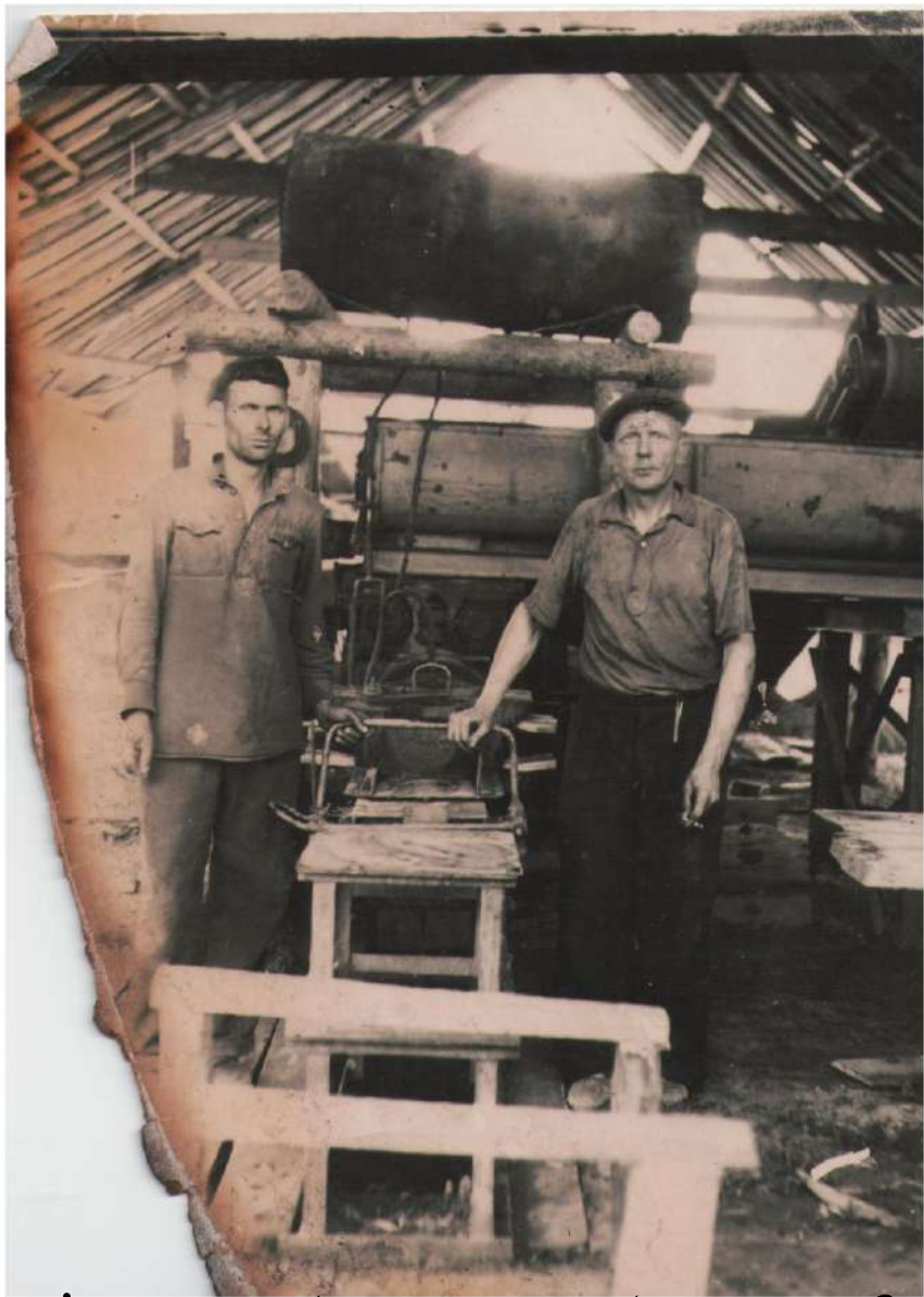
Петров Михаил и Мицкус Иван. Кирпичный завод.
